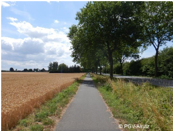
K 13 nördlich Meerdorf Gemeinsamer Geh- und Radweg entlang klassifizierter Straße
