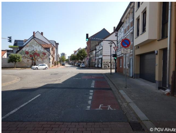
Kreuzung Rosenhagen/Werderstraße (Peine) Vorbeifahrstreifen mit aufgeweitetem Radaufstellstreifen (ARAS), Rotmarkierung bereits deutlich abgefahren
