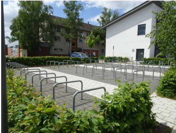
Grundschule Stederdorf Anlehnbügel ohne Überdachung
